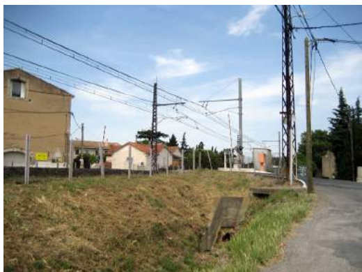
passage à niveau
