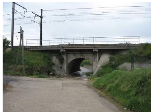
passage sous la voie ferrée
